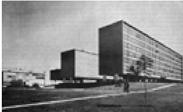
Figura 2: Brasília – Superquadra 114 – vista externa.
