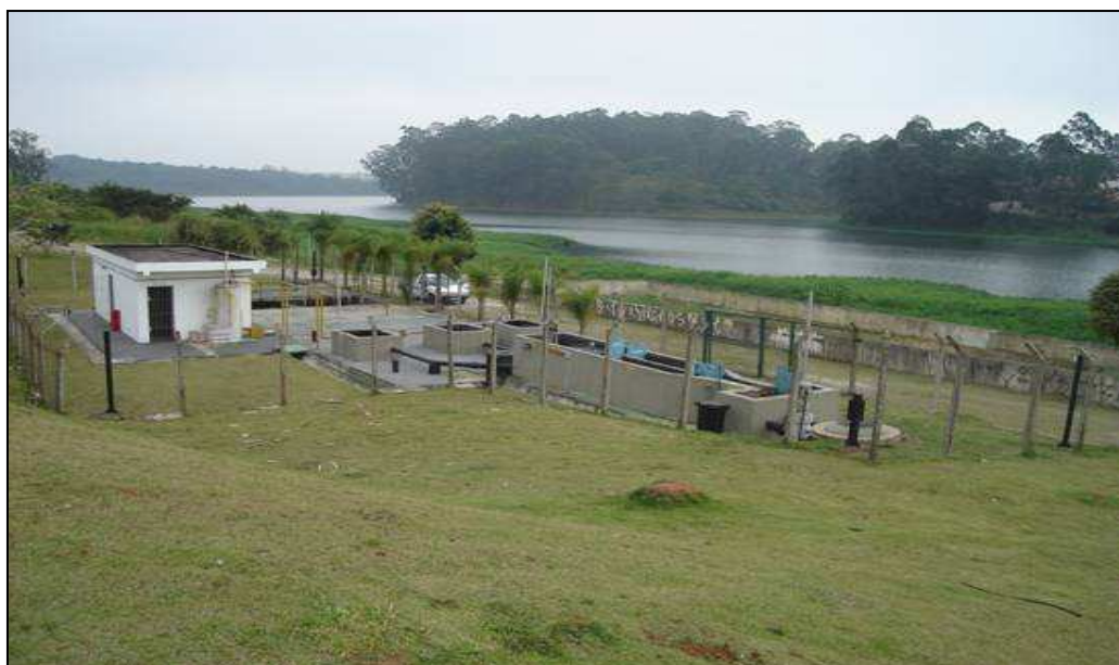
Figura 9 - Estação de tratamento de esgotos
