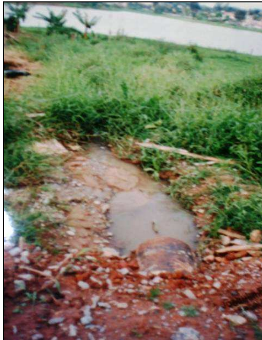
Figura 8 - Efluentes líquidos e sólidos são lançados a céu aberto
