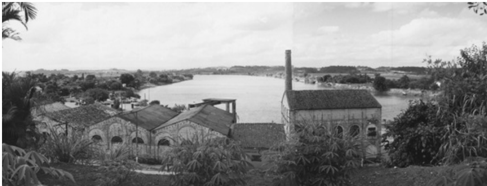
Figura 3: Conjunto KKKK em estado de abandono, década de 1990.
