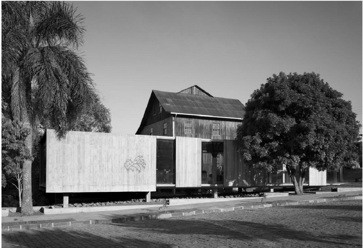
Figura 10: Museu do Pão após a intervenção.
