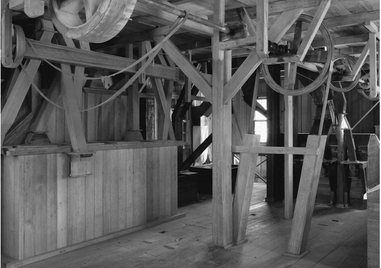
Figura 9: vista interior do Moinho após a recuperação.
