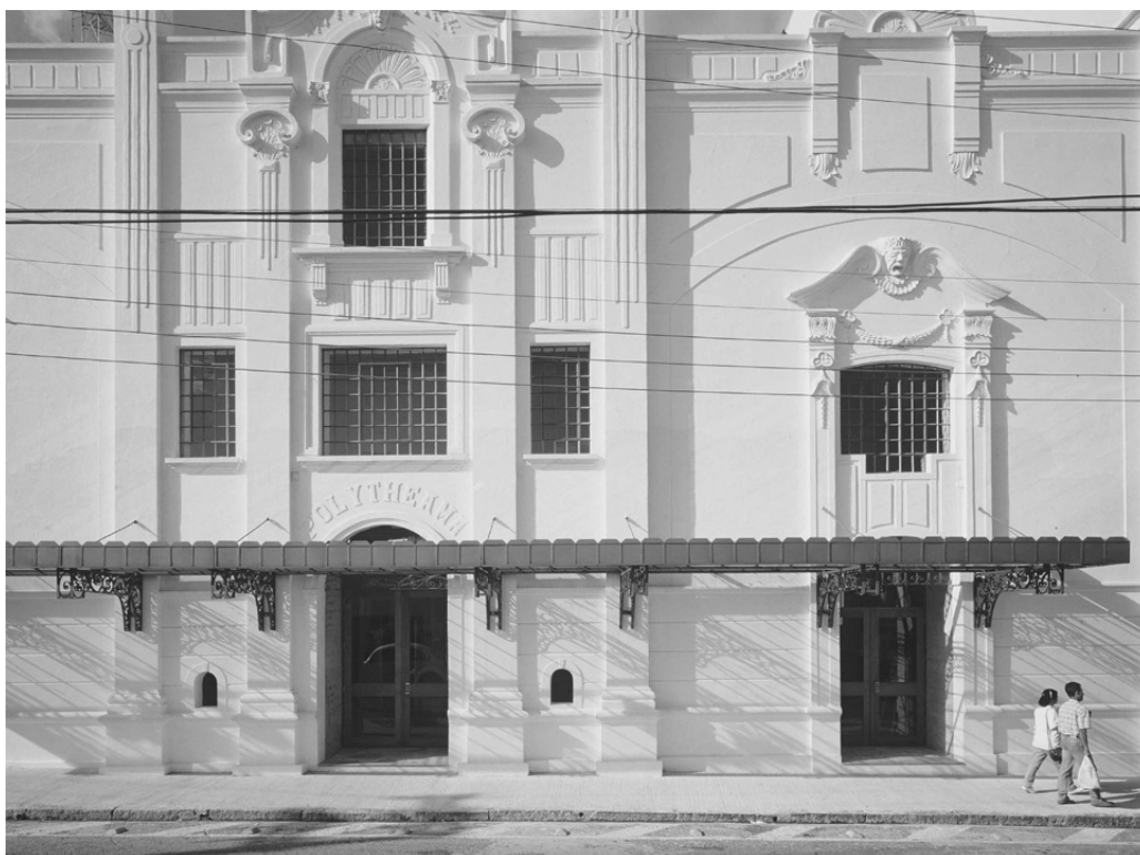
Figura 1: Teatro Polytheama, após a intervenção do Brasil Arquitetura.
