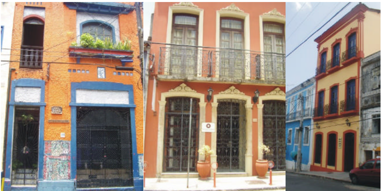
Figura 3 – Fotos de intervenções privadas no local - pousadas
