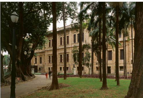
Fig. 5 Fachada para o Jardim da Luz Foto Vera Alvarenga e M. Isabel Villac
