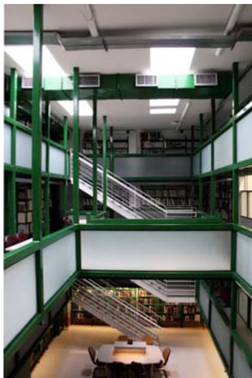
Imagem 17 Vista dos mezaninos do acervo de livros. Vãos para iluminação zenital foram abertos na cobertura. Foto: Sonia Gouveia
