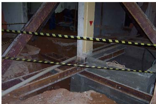
Imagem 12 Escoramento do pilar para execução do poço do elevador.
