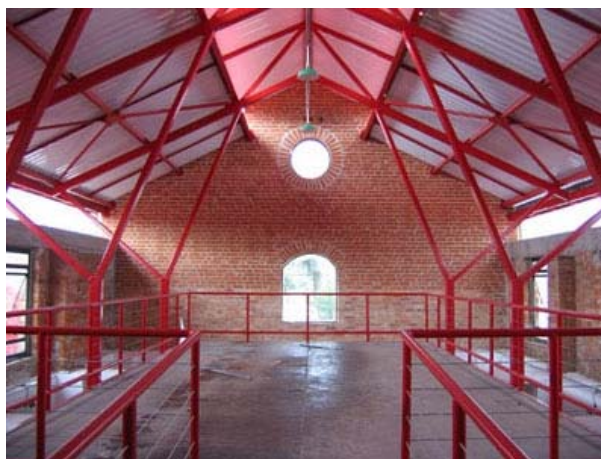
Figura 8: Foto interna do edifício reconposto
