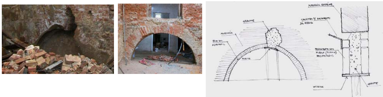
Figuras 5, 5a e 5b: Seqüência da recomposição dos arcos do porão
