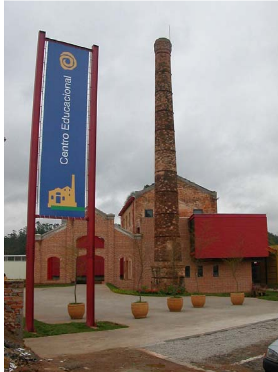
Figura 7: Foto externa do edifício recomposto
