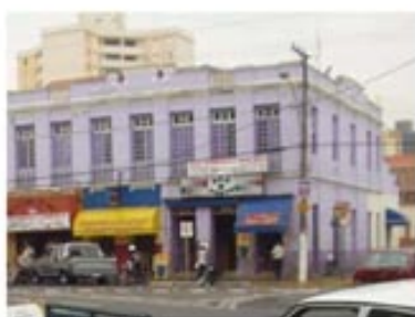
Situação atual Praça Pádua Salles, 73
