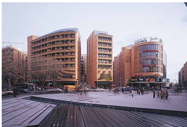
Figura 7: Vista da praça Marlene Dietrich. Fonte: Zohlen, 1999
