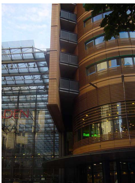
Figura 9: Detalhe fachada. Fonte: Autora, 2004
