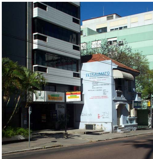
Fig.5 Na década de 1980, voltam os prédios colados na divisa, mas com no máximo 4 pavimentos. (foto do autor, 2006)
