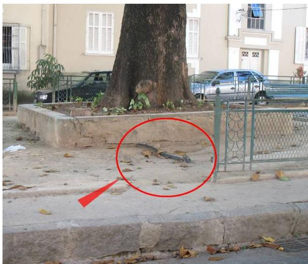
Figura 23 – Estado de descaso espaço público: afloramento de cabos de iluminação pública
