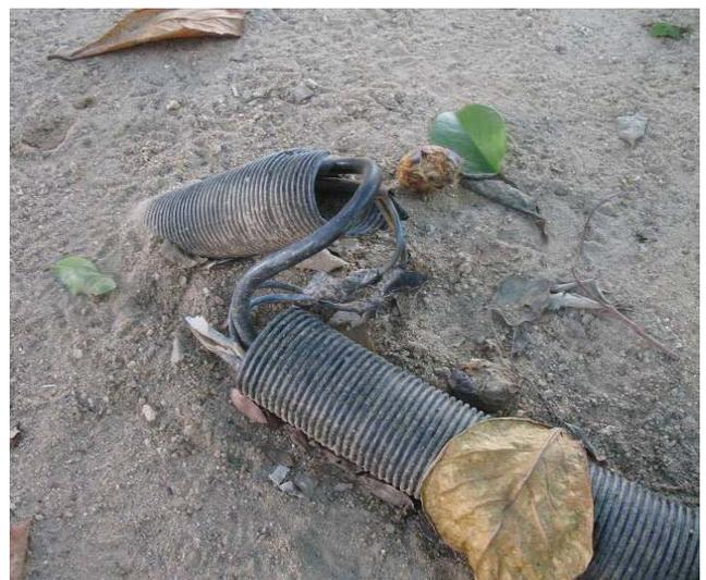
Figura 24 – Detalhe de cabeamento de energia elétrica exposto sobre o piso da praça.
