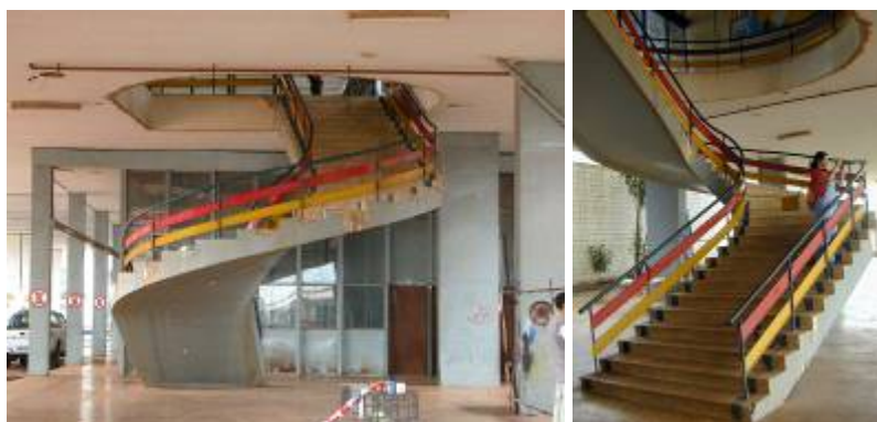
Figura 5 e Figura 6 – Touring Club do Brasil – Escada principal (Bloqueada no pavimento superior). 11
