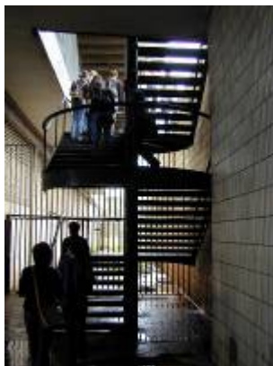
Figura 4 – Touring Club do Brasil – Escada de acesso à plataforma superior da Rodoviária. 10
