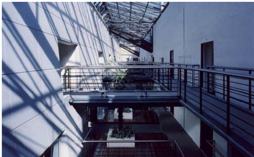
Figura 22: Galpão 8, pátio interno Fonte: Revista Summa+ 26.
