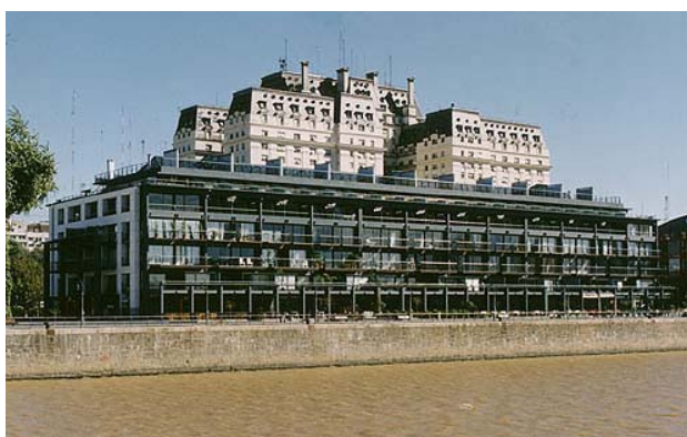
Figura 19: Galpão 8, Dique 3, vista da fachada leste. Fonte: arquivos cedidos pela Corporación Antiguo Puerto Madero S.A.
