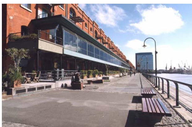
Figura 6: galpão portuário após da recuperação. Fonte: arquivos cedidos pela Corporación Antiguo Puerto Madero S.A.
