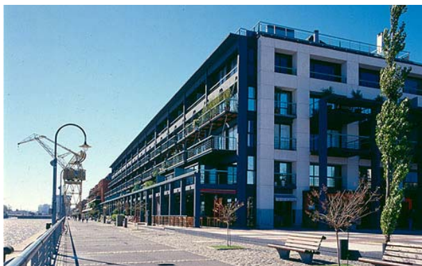
Figura 20: Galpão 8, Dique 3, vista fachadas norte e leste. Fonte: arquivos cedidos pela Corporación Antiguo Puerto Madero S.A.
