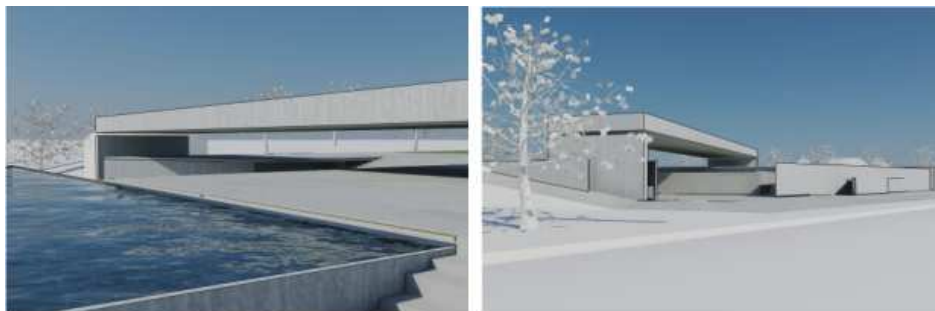
Figura 13 – Vista viga protendida 60m
