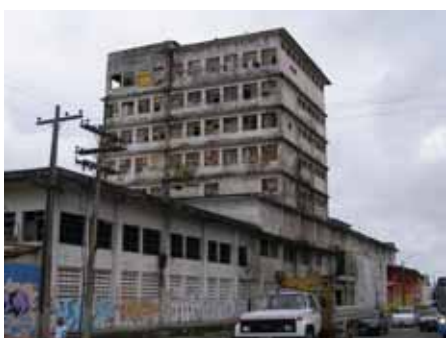
Figura 11: Edifício do Pescado Silveira, Cais de Santa Rita.
