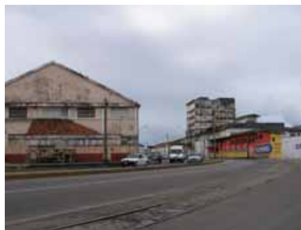
Figura 10: Armazém 16, com o edifício do Pescado Silveira ao fundo, no Cais de Santa Rita.
