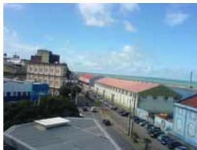
Figura 6: Armazéns 12, 13 e 14 (visto em parte, em azul).
