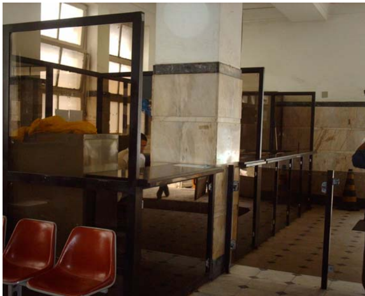
Fig.06 – Divisórias de vidro fumê em saguão de entrada do HC-UFBA (Foto dos Autores)
