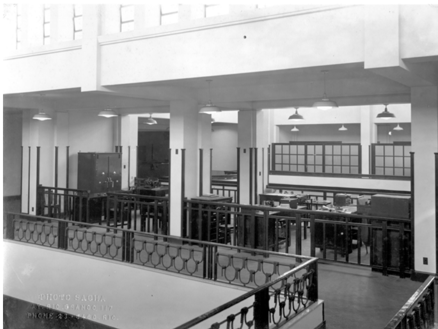
Fig. 9 - Edifício Mesbla, Arnaldo Gladosch, Rio de Janeiro. Vista interna do vazio e administração. Fonte: Henrique de Botton.
