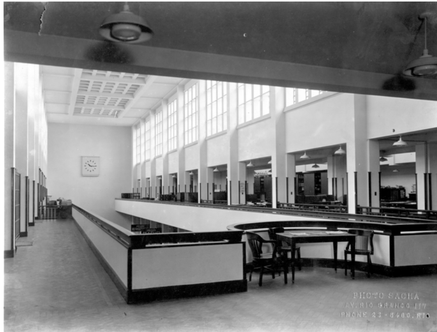
Fig. 8 – Edifício Mesbla, Arnaldo Gladosch, Rio de Janeiro. Vista interna do vazio e administração. Fonte: Henrique de Botton.
