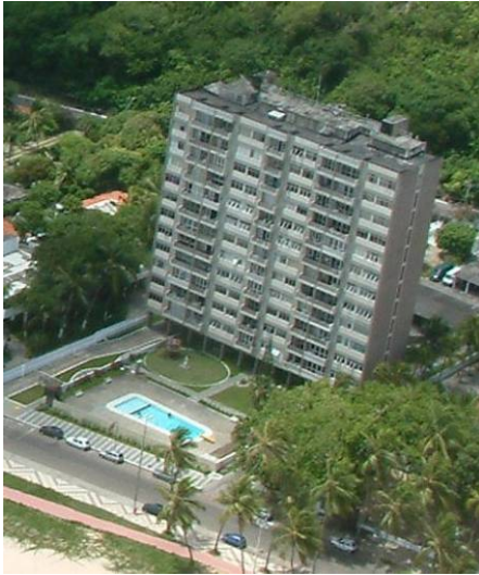
Figura 17: Edifício João Marques de Almeida. Fonte arquivo pessoal, 2007.
