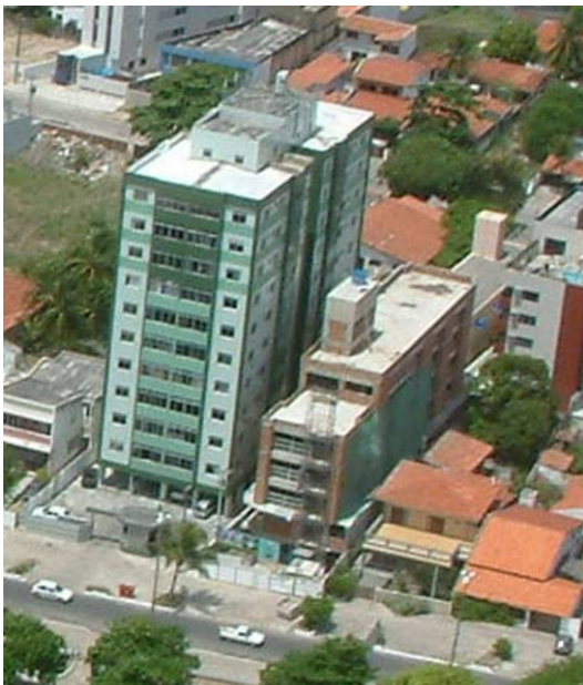
Figura 19: Edifício São Marcos. Fonte arquivo pessoal, 2007.
