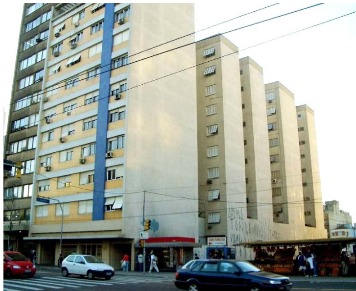
Fig. 8 – Avenida Independência: Edifício Britânia (nº 190) com empenas e áreas de iluminação na divisa, junto ao Túnel da Conceição.
