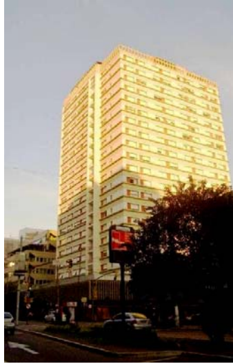
Fig. 5 – Praça Júlio de Castilhos: Edifício Vila Rica (nº 1275), cantoneira residencial sobre base comercial do Plano Diretor.
