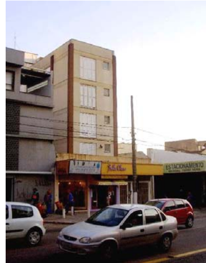
Fig. 13 - Av. Independência. Edifício com base e mini-torre em lote estreito.
