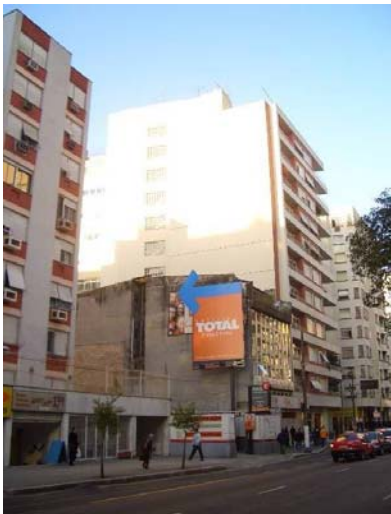
Fig. 16 - Av. Independência, esquina com Rua Santo Antonio. Empena cega do Edifício José Pilla (nº 720).
