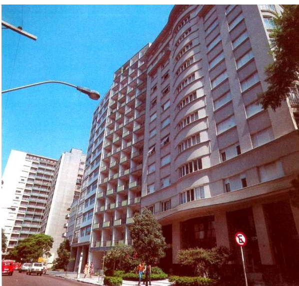
Fig. 9 – “Praça Júlio de Castilhos, com prédios construídos em época anterior à legislação urbanística. A não exigência de afastamentos entre edifícios conduzia à implantação de verdadeiras muralhas de concreto”. Legenda da foto no Álbum de Divulgação do 1º PDDU ilustra persistência do preconceito estético contra um dos espaços melhor configurados da cidade.
