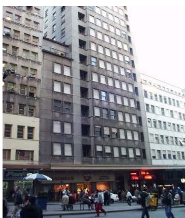
Fig. 5 – Ed. Sul América antes da reciclagem Lomando-Aita Engenharia
