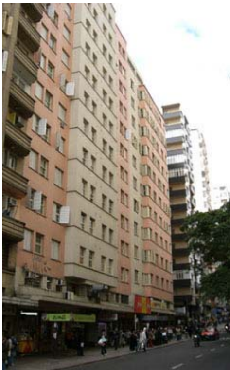
Fig. 14 – Ed. Bento Gonçalves e Charrua, depois da reciclagem Foto do arquivo da autora
