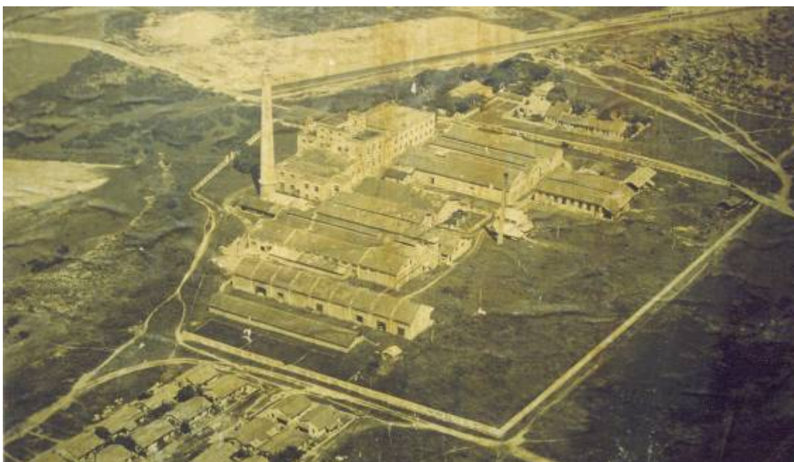
02 O conjunto antes da intervenção, vista aérea. Em: Fanucci. Ferraz, Brasil Arquitetura , p. 96.
