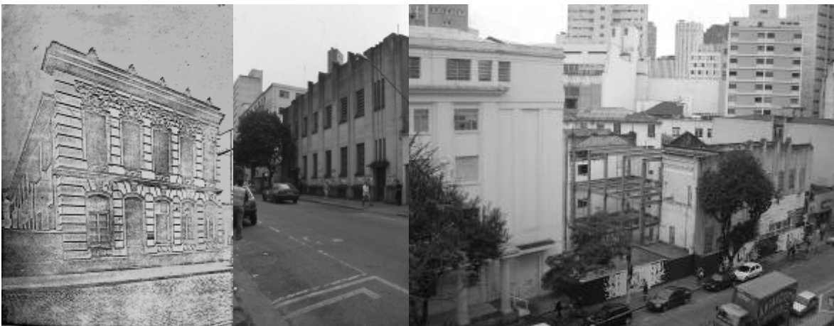
13 Fachada em 1928, fachada em 1936, fotografia de obra com a subtração feita que evidencia a fachada como pele
