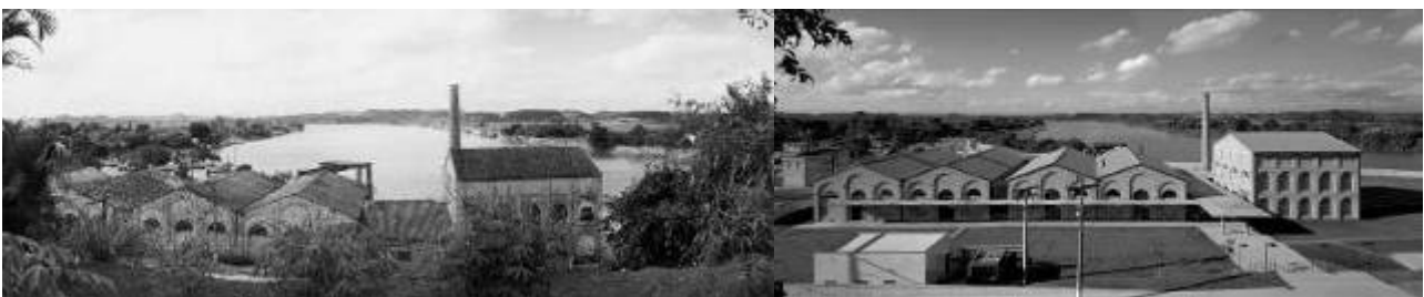
07 Bloco menor demolido (no centro da imagem). Marquise de ligação. Em: Fanucci. Ferraz, Brasil Arquitetura .
