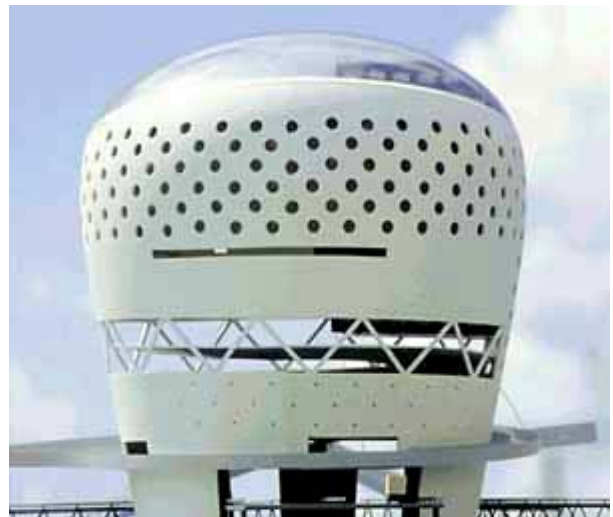
Fig.9: Terminal marítimo, Zeebrugge, Bélgica. Rem Koolhaas. Fonte: Prêmio Pritzker
