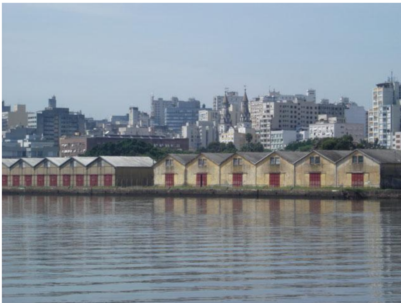
Fig. 4: À esquerda: Galpões originais do Cais do Porto; à direita, a seqüência a ser substituída no projeto de intervenção. Fonte: Andréa Machado, 2007.
