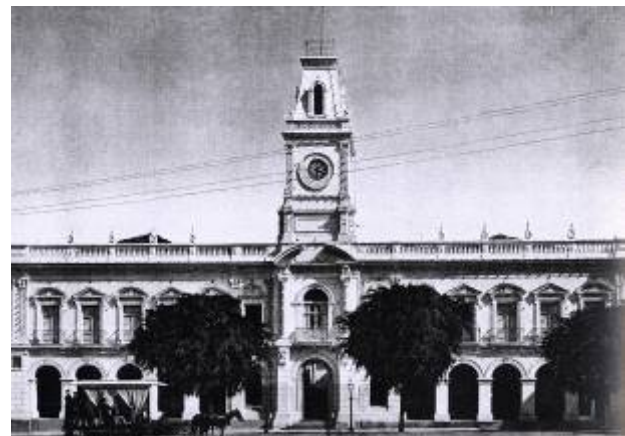
Figuras 23: Casa de Câmara e Cadeia depois da intervenção eclética sofrida ao final do século XIX (LEVASSEUR. 2001: 52).
