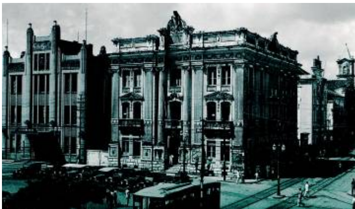
Figura 25: Imprensa Oficial (esquerda), Biblioteca Pública (direita) e Fórum. Edifícios demolidos abrindo a grande praça à frente do Palácio Rio Branco (Cartão Postal).
