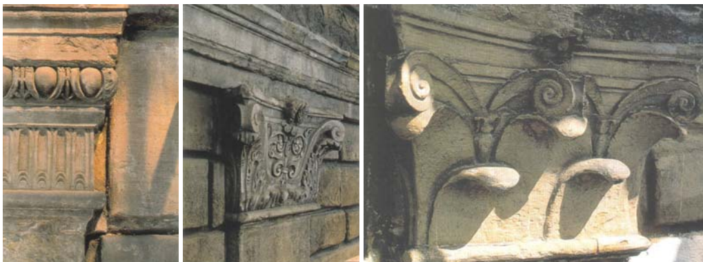
Figuras 33, 34 e 35 Capitéis do térreo, segundo e terceiro pavimentos do Palazzo Rucellai. Fonte: TAVERNOR, 1998, p. 85.
