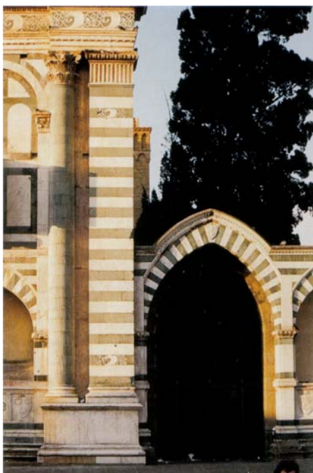
Figura 19 Detalhe da pilastra-cantoneira e dos arcos ogivais preexistentes em frente ao cemitério, que dão seqüência aos arcos da fachada principal. Fonte: TAVERNOR, 1998, p. 100.
