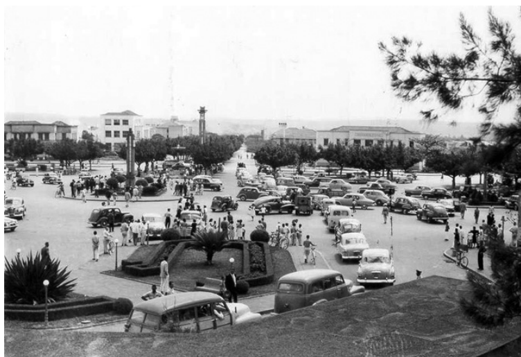
Figuras 6. Vista da Avenida Goiás desde o Centro Cívico em uma imagem de 1952. Percebe-se a escala “doméstica” dos edifícios – incluindo aqueles administrativos no primeiro plano– assim como a ausência de uma caracterização arquitetônica mais expressiva. Fonte: Biblioteca SEPLAN.
