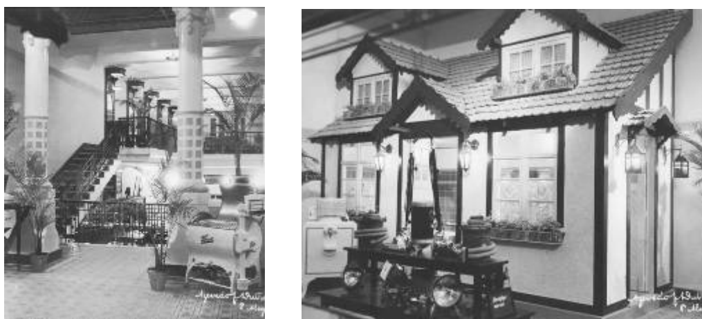
Figura 1: Fotos antigas dos interiores do Edifício Força e Luz
