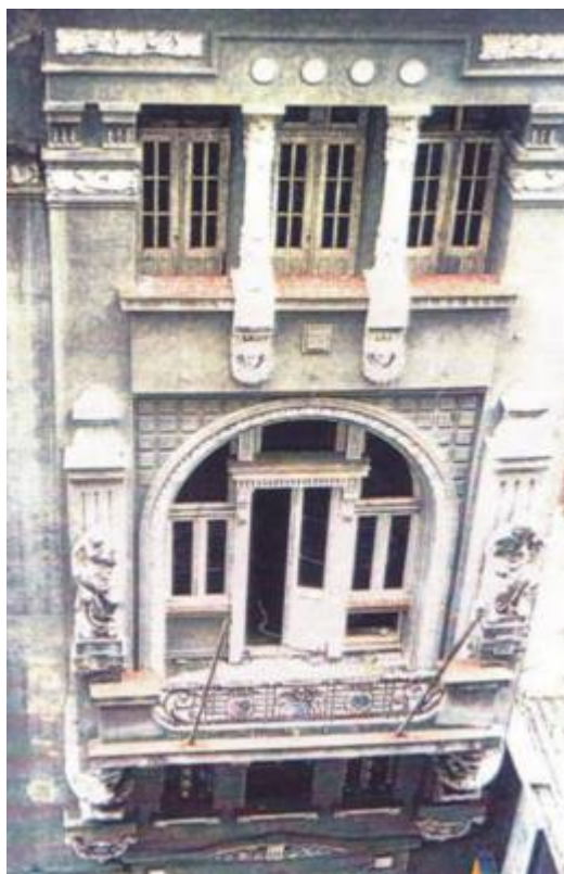
Figura 2: Edifício Força e Luz
