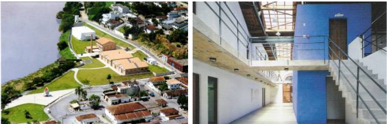
Figuras 41 e 42 – Vistas geral e do interior de um dos armazéns do Memorial da Imigração Japonesa em Registro, São Paulo – Brasil Arquitetura (Francisco Fanucci & Marcelo Ferraz), 1999-2000 (Fonte: CORBIOLI, 2002; SEGRE, 2003)
