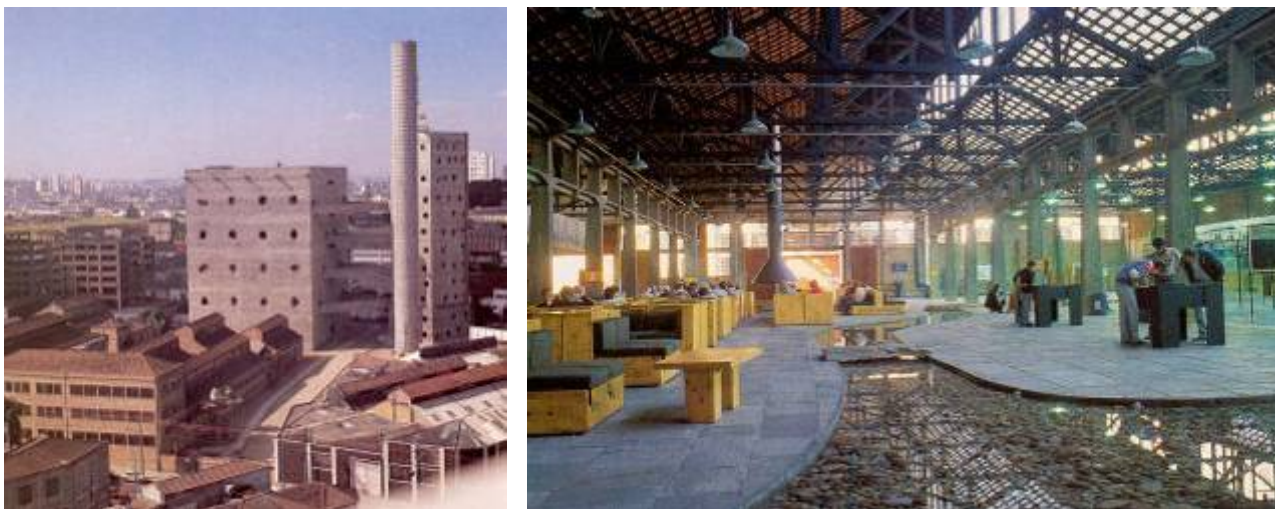
Figuras 33 e 34 – Vistas geral e do interior de um dos galpões do SESC Pompéia em São Paulo – Lina Bardi e colaboradores, 1977-1986 (Fonte: PROJETO, 1986)
