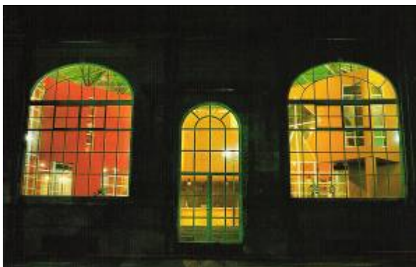
Figura 12 – Mercado de Alta Córdoba em Córdoba, Argentina – Miguel Angel Roca, 1980-1985 (Fonte: TAYLOR, 1992)
