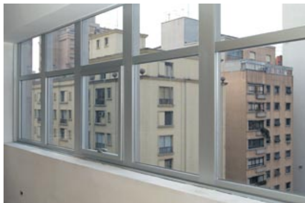
Figura 8 - Detalhe da caixilharia recuperada, com folha de janela maxim-ar.
