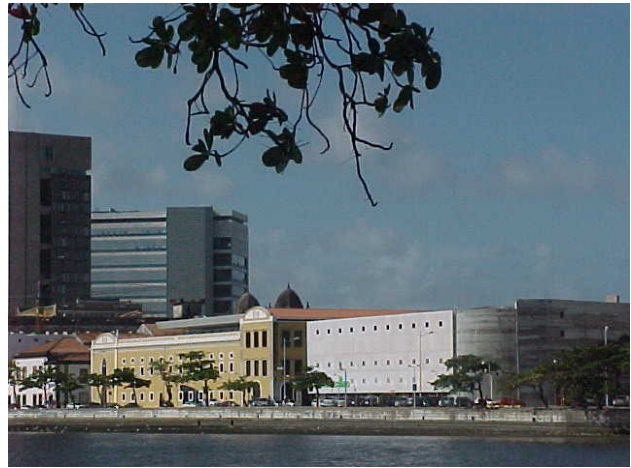
Figura 06 Paço Alfândega à esquerda e edifício garagem à direita revestido com a chapa perfurada.
