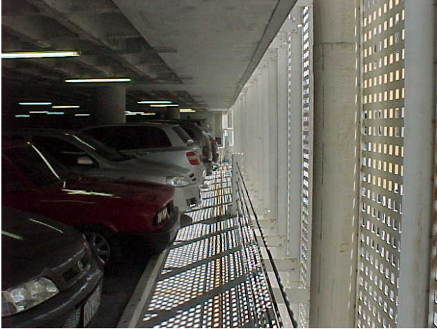
Figura 05. Chapa perfurada vista do interior do edifício garagem.
