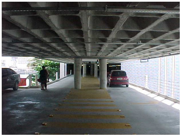
Figura 04 Faixas de Rolamento das passarelas.
