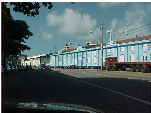
Figura 12. Galpões do porto no entorno.
