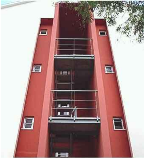
FIG 8 – Marcação da saída de emergência
