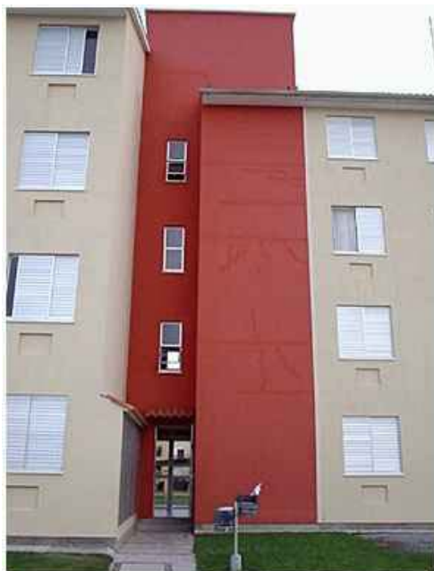
FIGURA 7 – Abertura de portas e janelas diretamente sobre o espaço do recuo de ajardinamento
