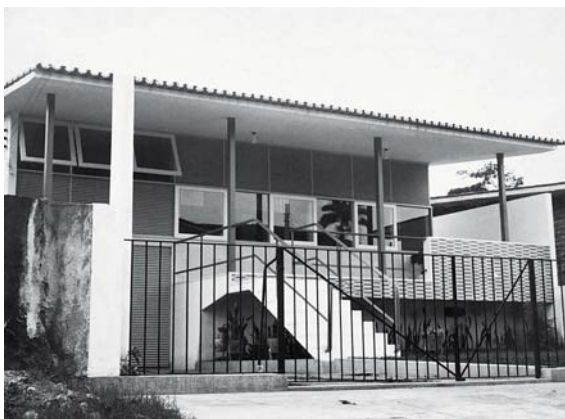
Figura 2. Residência Serafim Amorim, de Delfim Amorim, demolida em 2003 (Fonte: Arquivo Delfim Amorim)
