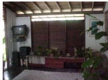
Figura 11. Exemplo de esquadria com veneziana móvel (fechada). Fonte: Arquivo do autor.
