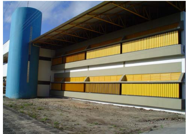
Figura 20. Captadores de vento acoplado à cobertura para ventilar espaços a sotavento. Fonte: Arquivo do autor.
