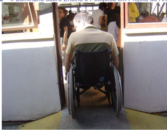
Figura 17- Rampa íngreme-Acesso principal do refeitório é estreito e a rampa é muito inclinada.
