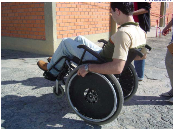
Figura 16- Pavimentação Inadequada- Falta de passeio e pavimentação inadequada obrigam M. a empinar a cadeira de rodas.
