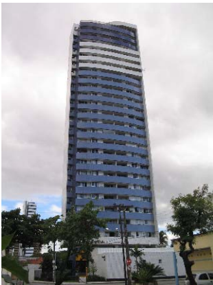
FIGURA 05: Edifício Artemis. 1999. Foto: Marcio Erlich
