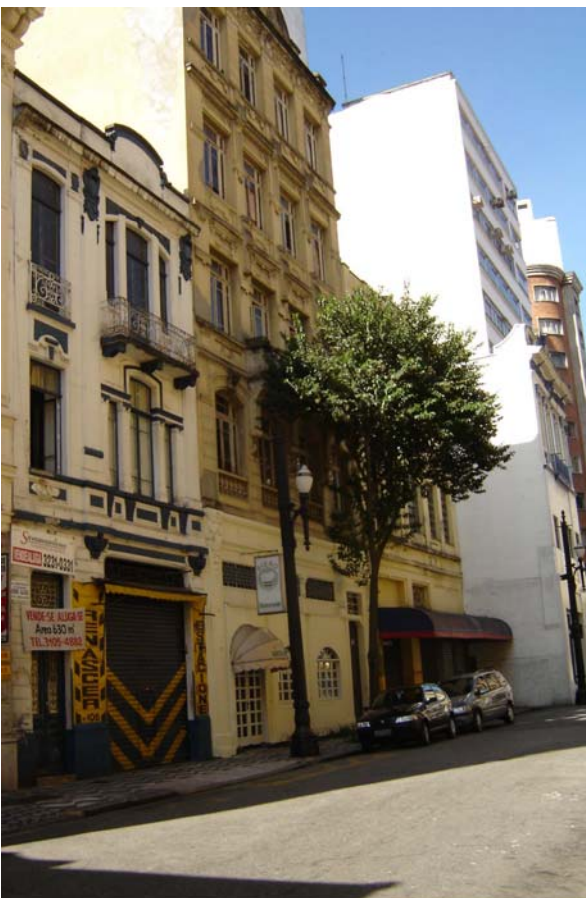
FOTO 12 - fachada edifício Rua Roberto Simonsen (foto de A.C.M.L.Moreira)
