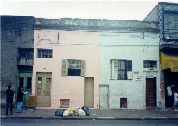
FOTO 15 - fachada cortiço Rua João Teodoro 1005 (foto de CDHU-Seade)
