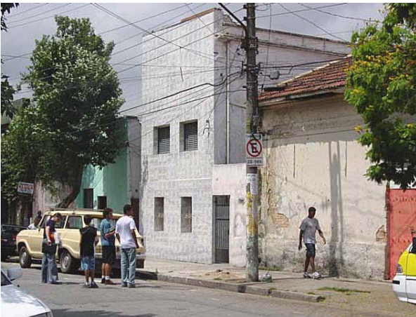
FOTO 16 - fachada cortiço Rua Madeiras (foto de A.Sciulli, G.Callegari, I.Campos, R.Mentone)
