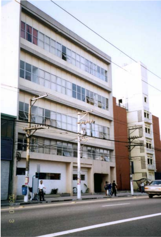
FOTO 7 - fachada do edifício BANESPA na Av. Celso Garcia
