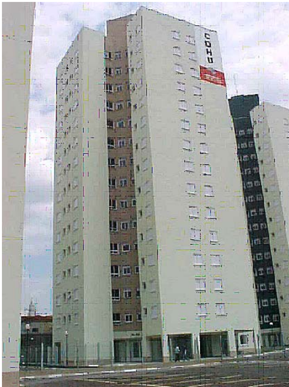
FOTO 8 - vista do edifício da Rua Sampaio Moreira (foto CDHU)
