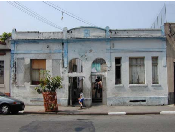
FOTO 2 - fachada cortiço Rua Canindé (foto de Cândida Maria Vuolo)
