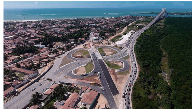
Construção do Viaduto da Redinha Fonte: www.tribunadonorte.com.br
