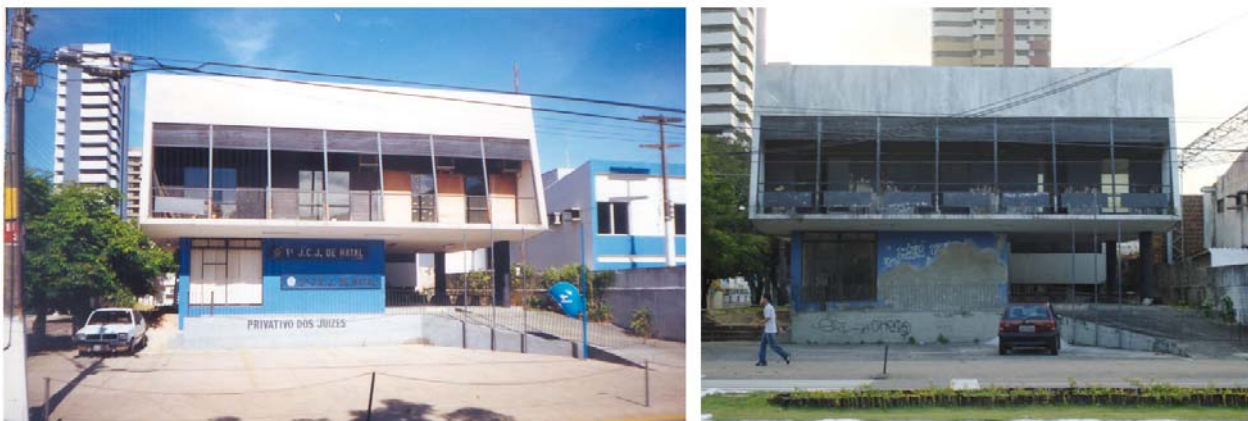
Figura 8: Imóvel abandonado e mal conservado, situado à Avenida Hermes da Fonseca
