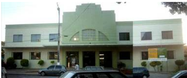
Figura 11: Edifício CBTU. Fonte: PRAC – Ribeira, 2006.
