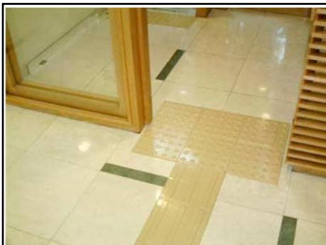
Figura: 08 – Sinalização Tátil de alerta e direcional não atende aos padrões de exigências técnicas da NBR 9050/04, prejudicando a ocorrência do Behavior Setting e o auto-atendimento. Fonte: SALERNO JUNIOR, 2008.
