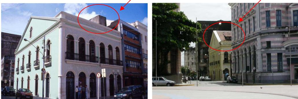
**Figuras 3 e 4:** Galeria Ranulpho, fachada logo após a intervenção. Volumetria alterada pela inserção do elevador (ver detalhe figura 3) e inserção de terraço superior (ver detalhe figura 4).
