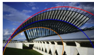
Figura 16: Curvas cônicas na cobertura da Estação TGV de Lyon, Satolas. [16]
