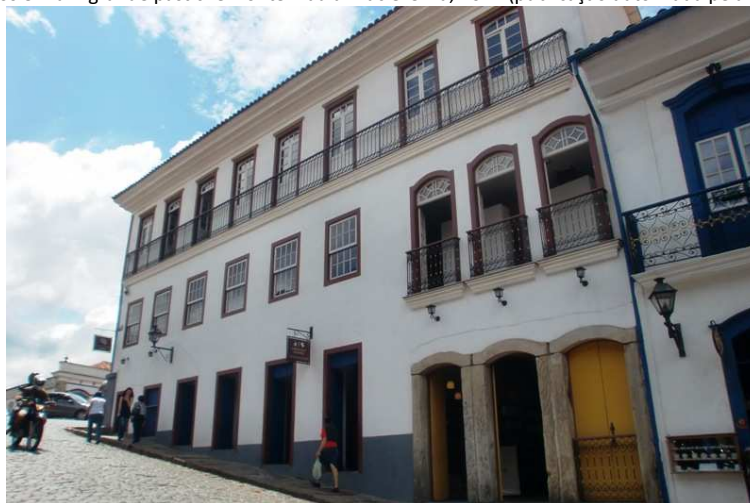
Figura 1: Casarão reconstruído na Praça Tiradentes. Note-se na imagem a única área remanescente da edificação que sofreu o incêndio: as três portadas em pedra no canto direito inferior da imagem. O remanescente e o reconstruído estão completamente fundidos em um grande pastiche. Fonte: Paula Maciel Silva, 2012 (publicação autorizada pela autora).
