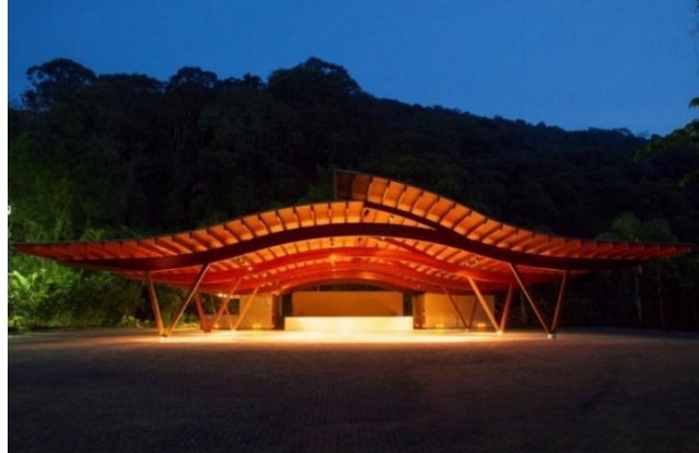
Figura 3: Imagem do Pavilhão de Eventos Iporanga
