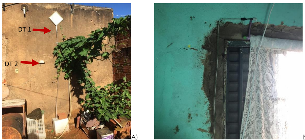
B) Posição do sensor na face interna da parede
