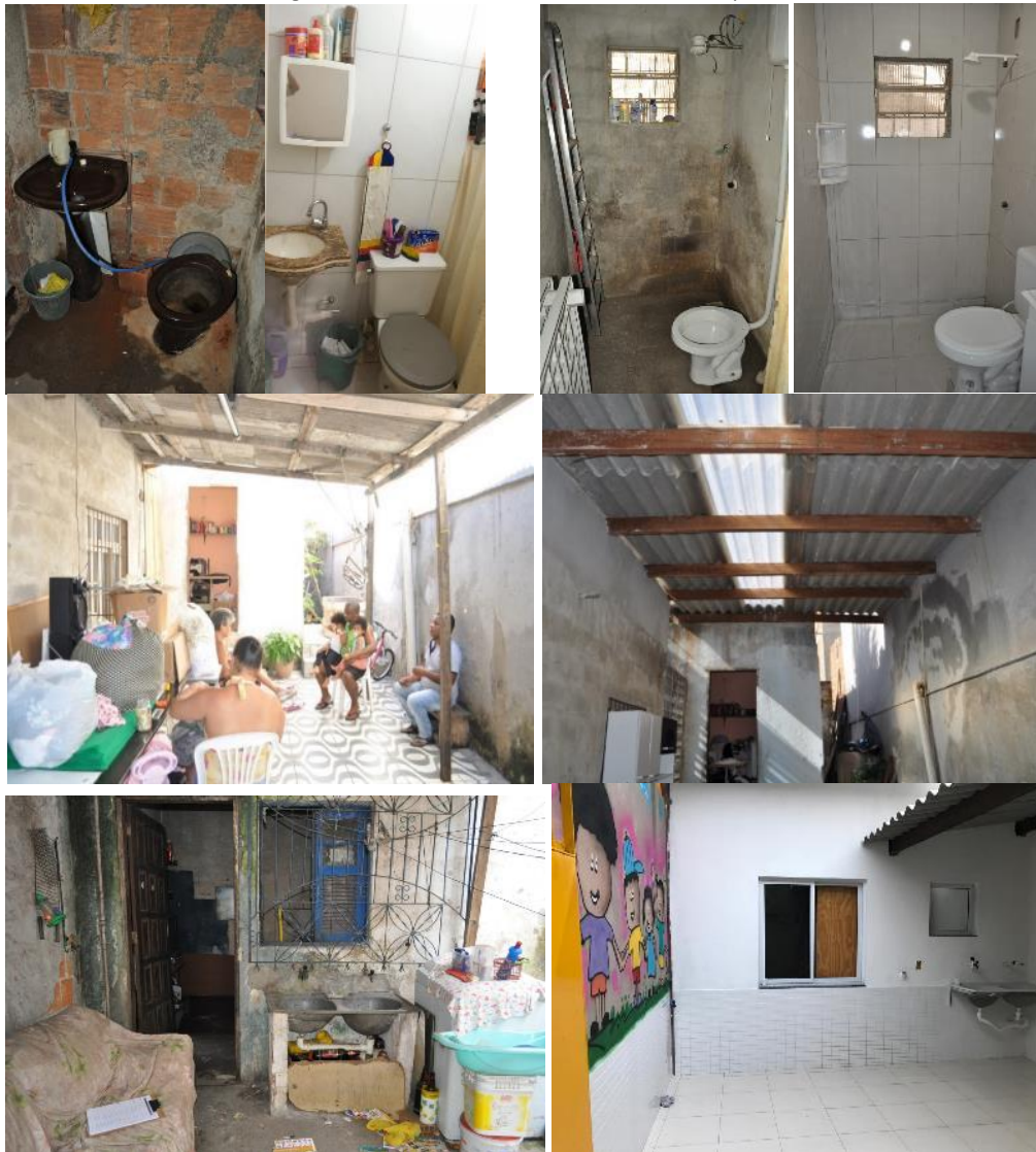
Figura 9: obras sendo executadas – antes e depois.
