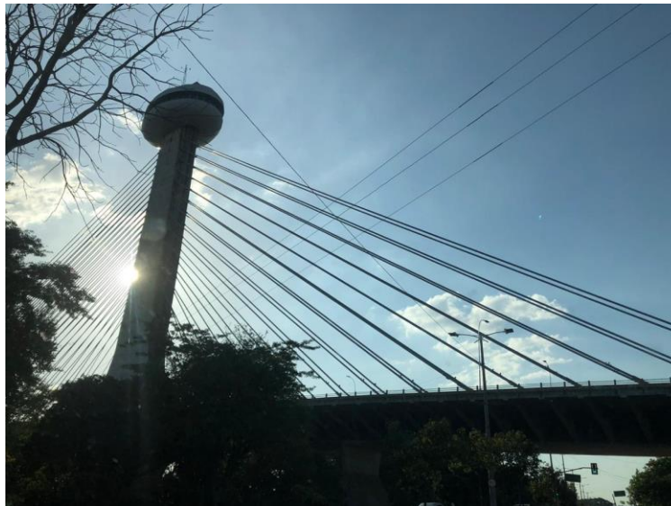
Figura 1: Ponte estaiada em Teresina
