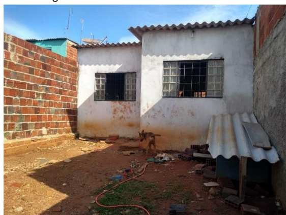
Figura 2: Fachada frontal da residência A
