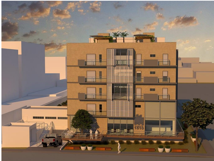
Figura 3 – Folding shutters e telas solares minimizam a incidência solar na fachada sudeste.
