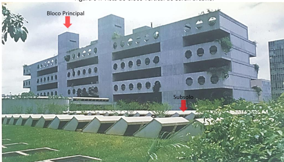
Figura 04: Vista do bloco vertical do Sarah Brasília.
